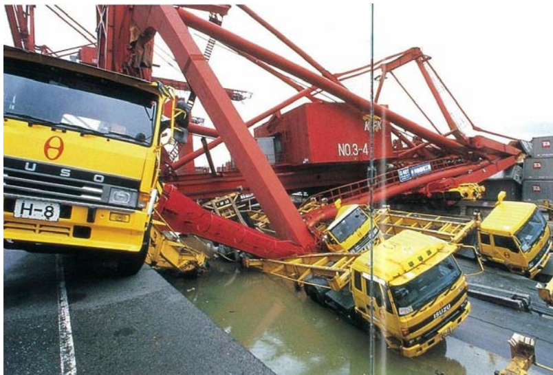
神戸の岸壁の移動とガントリークレーンの倒壊
